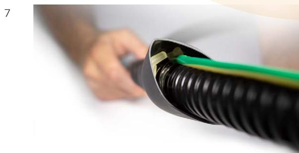
В образовавшуюся воронку всыпать термоплавкий клей и равномерно распределить его в манжете.
